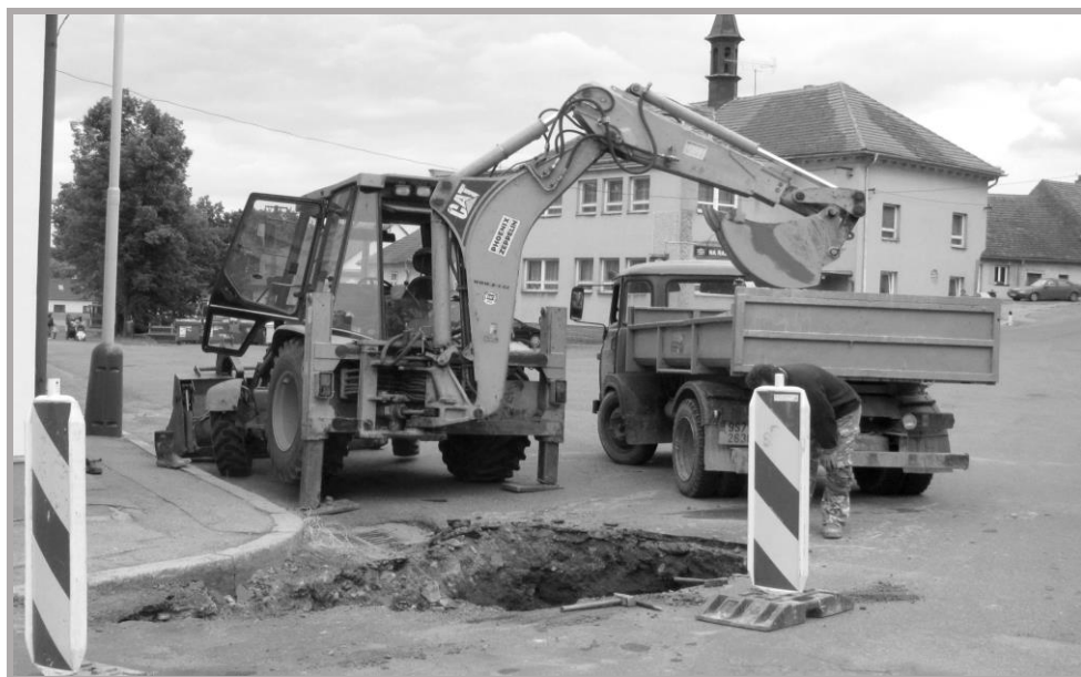
Oprava vodovodního řadu před obchodem paní Číperové dne 14. 6. 2014
