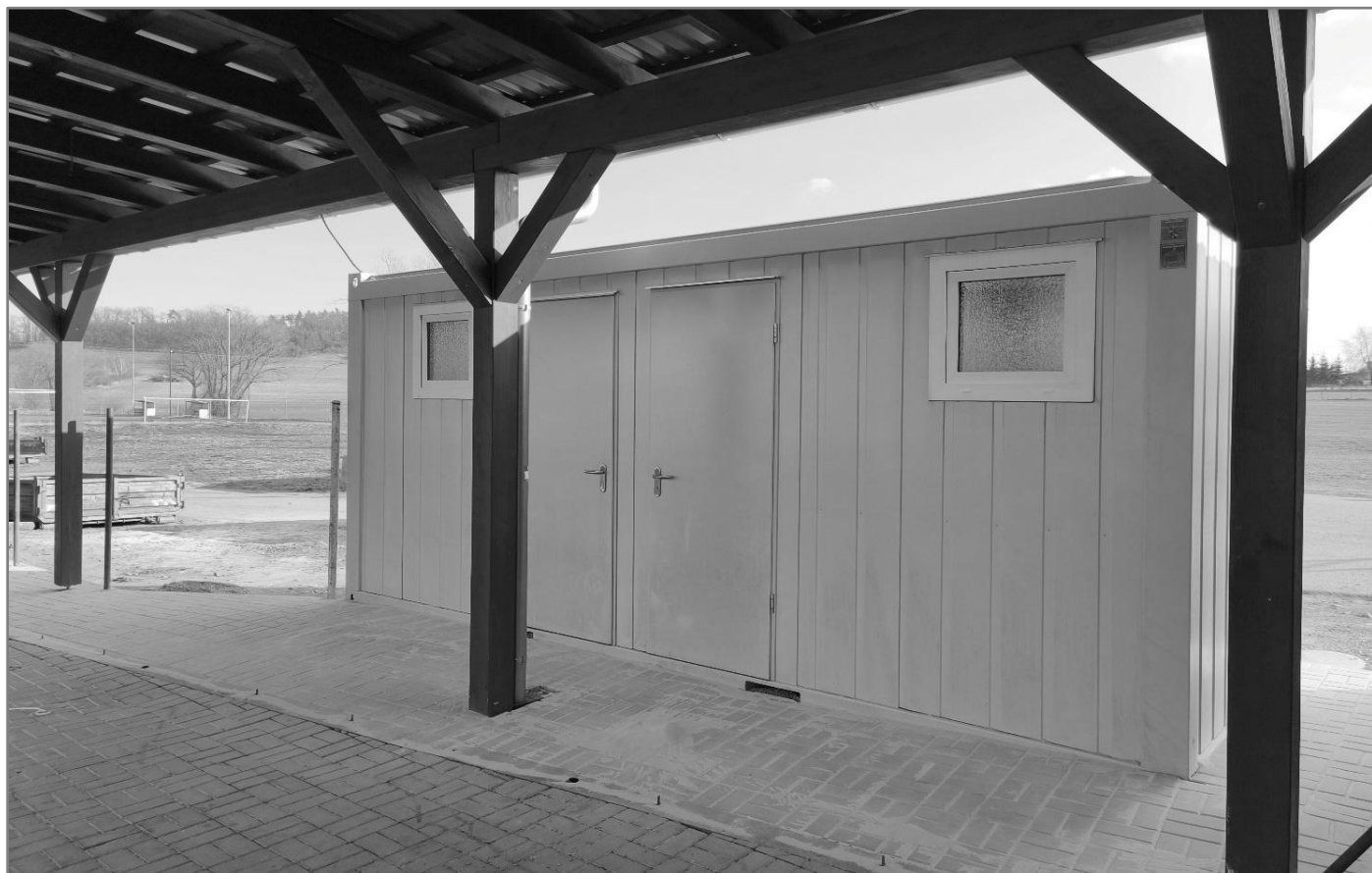
Nový sanitární kontejner u fotbalového hřiště Trávníky v Maršovicích
