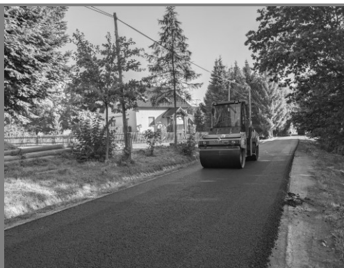
Asfaltování krajské silnice ve Zderadicích
