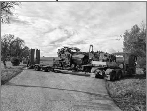
Asfaltování krajské silnice do Zaječí
