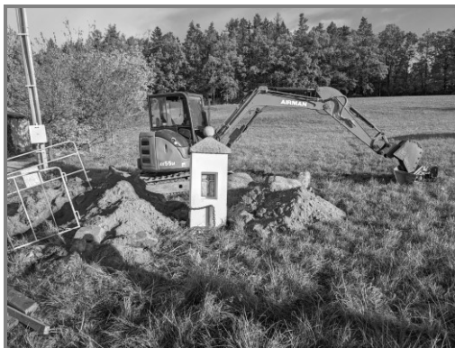
Oprava nabourané kapličky na Křížích
