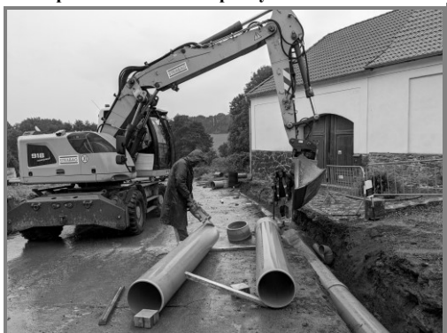
Výměna potrubí dešťové kanalizace ve Mstěticích
