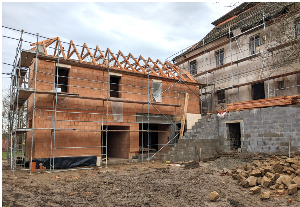
Rekonstrukce na faře
