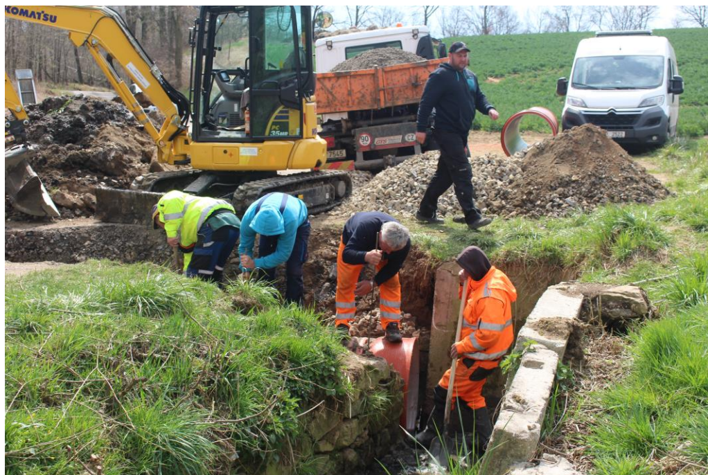
Oprava propustku na místní komunikaci mezi Zahrádkou a Dlouhou Lhotou
