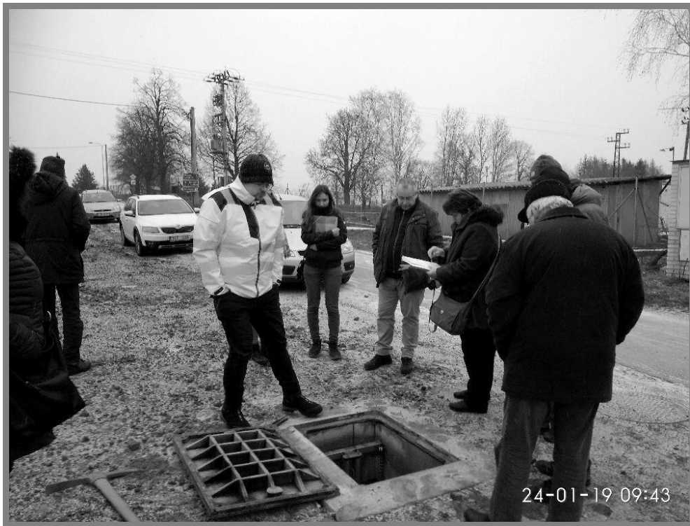
Závěrečná prohlídka splaškové kanalizace a ČOV Maršovice před uvedením do zkušebního provozu
