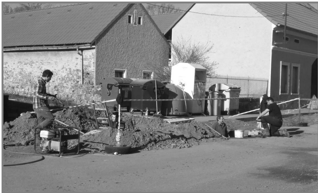
Městys před pokládkou nových asfaltů preventivně vyměňuje staré části maršovického vodovodu
