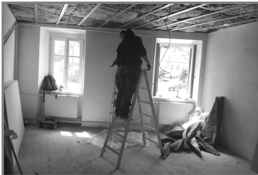
Zateplování sádkartonového stropu v obecním bytě Maršovice 74
