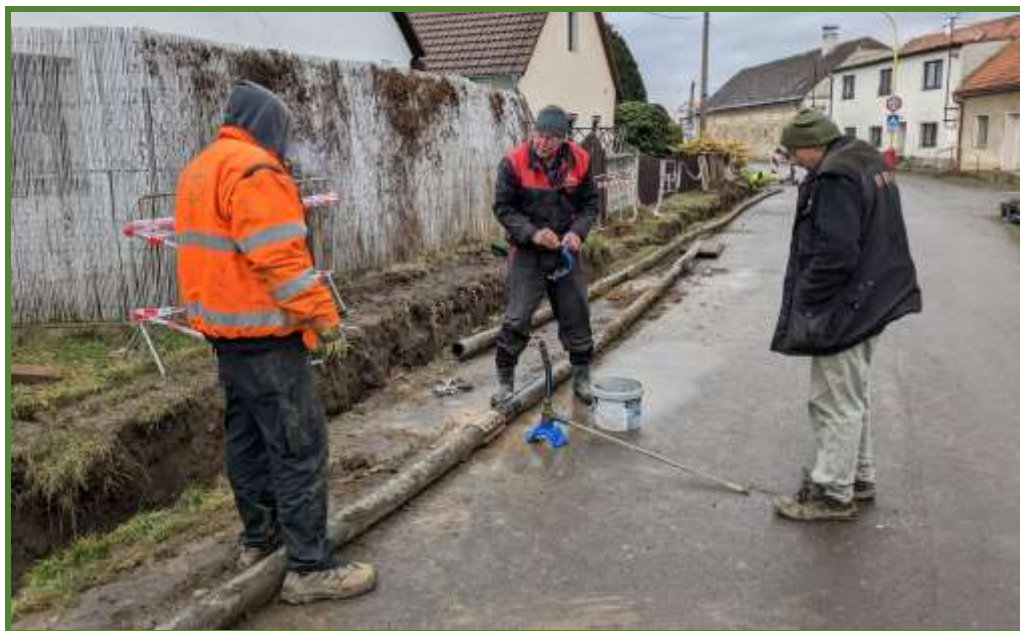
Výměna vodovodního řadu v Maršovicích
