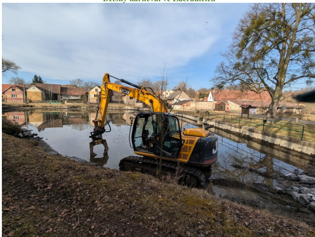
Úprava hráze rybníka ve Strnadicích
