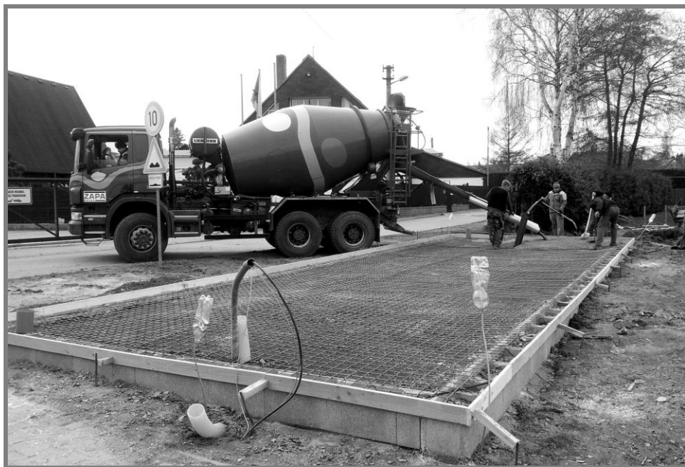
Základová deska nových kabin
