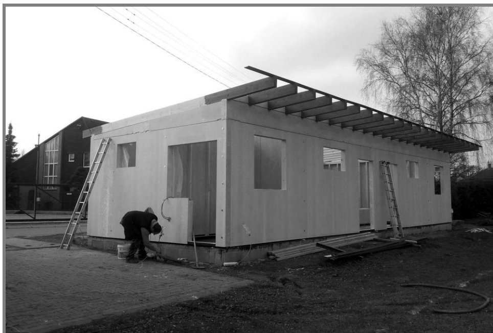
Hrubá stavba nových kabin na hřišti Trávníky
